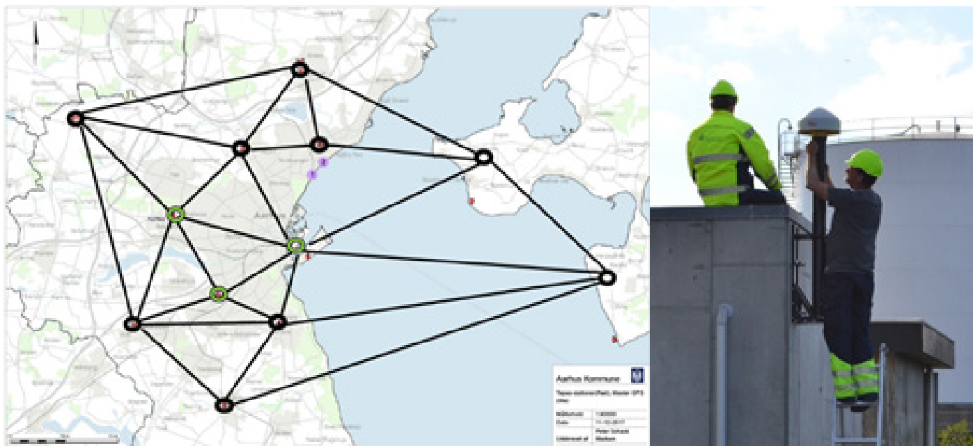
Figur 2: Data fra referencestationerne (som vist på billedet til højre) gør det muligt at beregne korrektioner af satellitsignalerne.
